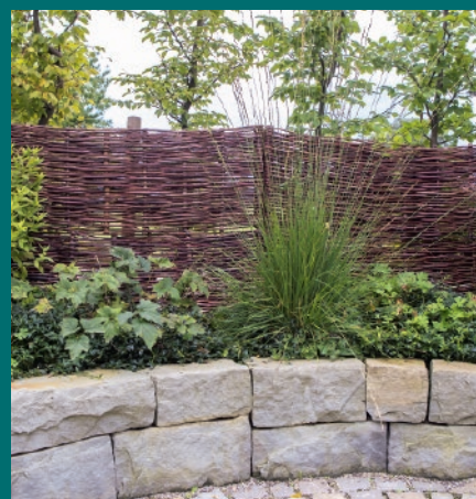
Flechtzaun mit Natursteinmauer
