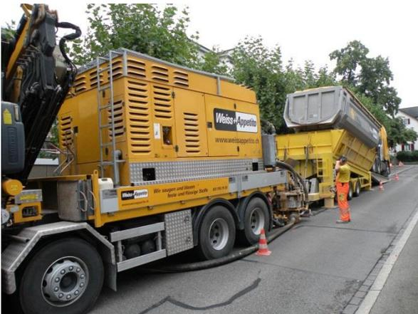
*Lastwagen mit Pumpvorrichtung (Gebläse) und Anhänger mit Kippmulde die mit LKW-befahren werden kann. Das Dachgartensubstrat wird per Schlauch auf das Dach geblasen.*
