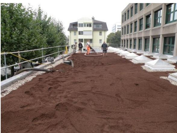
*Substrat nach dem verteilen mit Pumpvorrichtung. Verschiedene Substrat-Schichtstärken für die diverse Pflanzenarten werden per Hand erstellt.*
