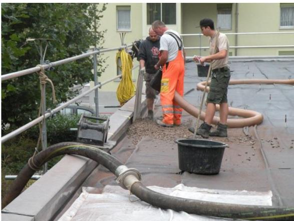
*Schlauchende des Gebläses. Alessio bei der Instruktion der Spezialfirma.*
